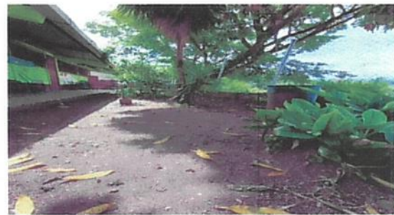
Foto 4: MODULO 2 EN ESTA PARTE DEL PATIO NO SE CUENTA CON PISO TORTA DE CEMENTO Y DURANTE EL INVIERNO ES PROPENSA A LA SUCIEDAD Y PEQUEÑOS ANIMALITOS
